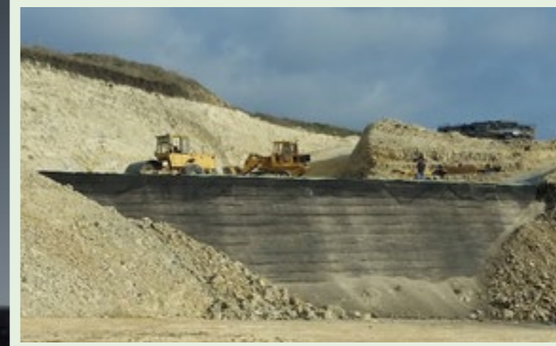
Geo duvar İnşaatı
